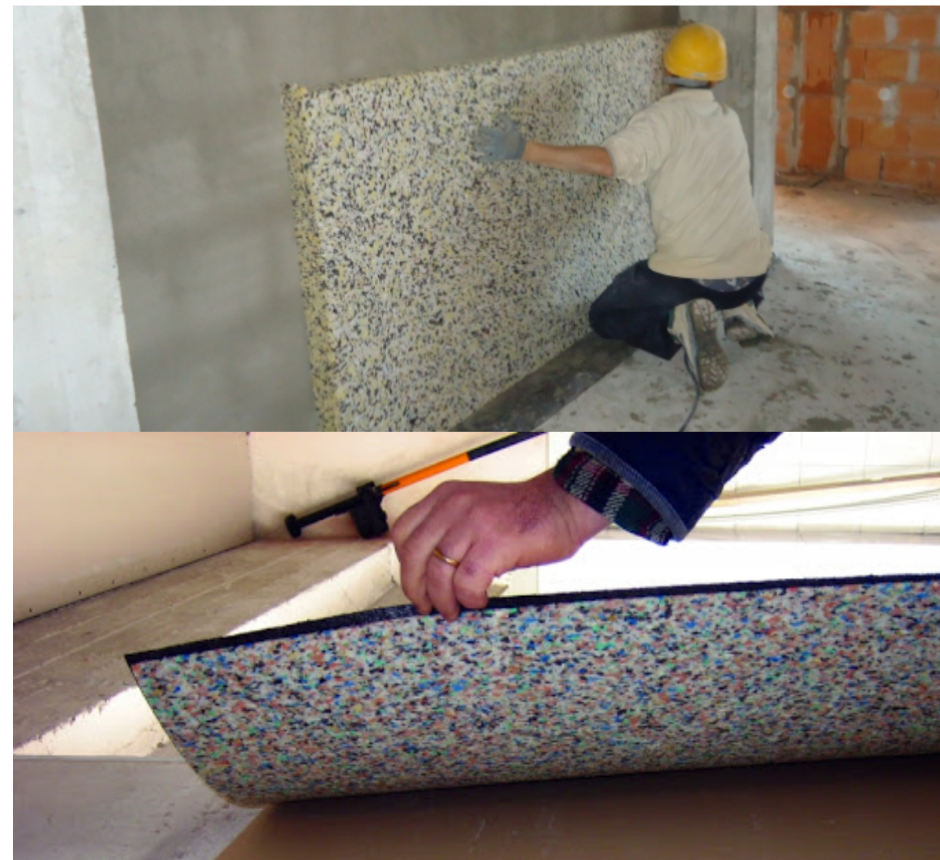
Le lastre isolanti in poliuretano riciclato sono di facile posa, sagomabili ed adattabili alle diverse forme dell'edificio
